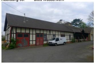
Ein weiteres eingeschossiges Gebäude mit einem angeschleppten Anbau weist eine Grundfläche von rund 160 m² auf. Das Bauwerk ist mit Ziegelmauerwerk ausgeführt. Es handelt sich um ein ehemaliges Pumpenhaus aus dem 19. Jahrhundert. In dem Gebäude befindet sich ein Brunnen, welcher vom Trinkwassernetz getrennt ist.
