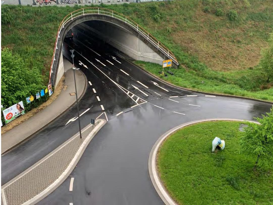
**Abbildung 1: Zweistreifige Ausfahrt K6 mit geänderter Fahrstreifenaufteilung (Status Quo)**
